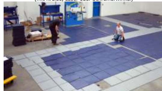
Bild Nr. 4 Gliedern Sie bitte die Palette auf und verlegen Sie die Fliesen lose, bevor Sie mit dem Fixieren anfangen
