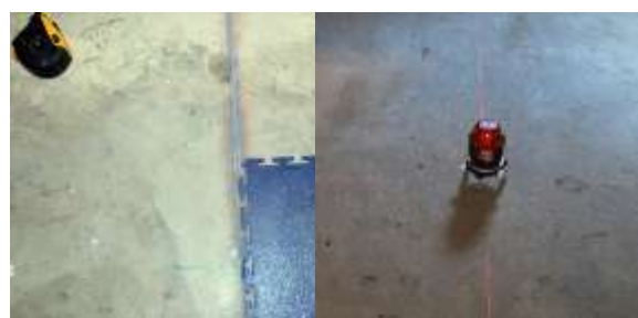
Bild Nr. 3 Versichern Sie, dass die Fliesen ausgeglichen verlegt werden (mit Kreide, Laser oder Schreinerwinkel)
