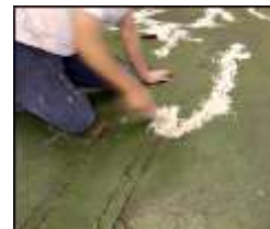
Bild Nr. 2 Kehren Sie bitte den Boden und entfernen bzw. reparieren alle Unebenheiten
