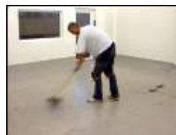
Bild Nr. 2 Kehren Sie bitte den Boden und entfernen bzw. reparieren alle Unebenheiten
